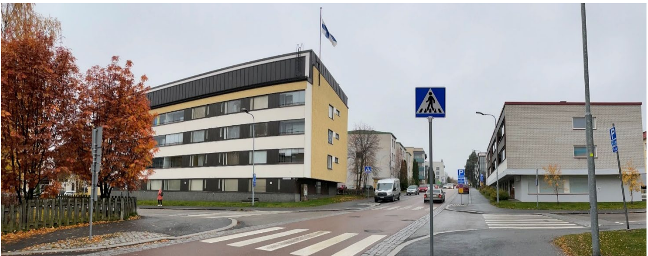
Kuvassa Kalervonkatu 3 -rakennus, joka on Kalervonkadun ja Yrjönkadun risteyksessä kulmittain suunnittelualueen kanssa. Rakennuksessa on neljä maanpäällistä kerrosta ja lisäksi konttikatto, joka on kadun puolella korkeimmillaan. (10/2025)
